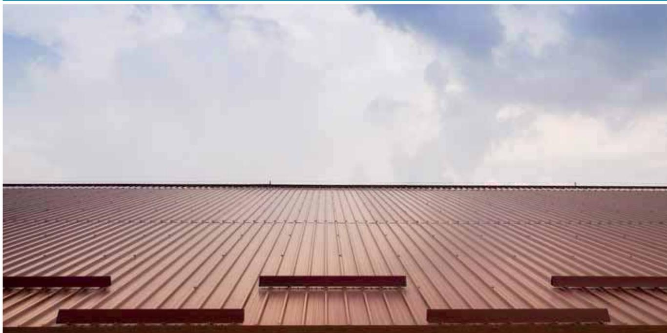
Pannello sandwich a doppio rivestimento metallico, per coperture con pendenza non inferiore a 7%, coibentato in poliuretano, con lamiera esterna profilata a 5 greche. Il fissaggio è a vista, con appositi cappellotti metallici e guarnizione. Trova impiego anche nel rivestimento di pareti.
